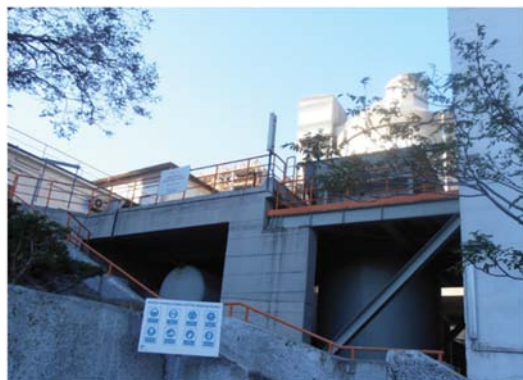
Slika 6. – Sustav za doziranje REA gipsa
